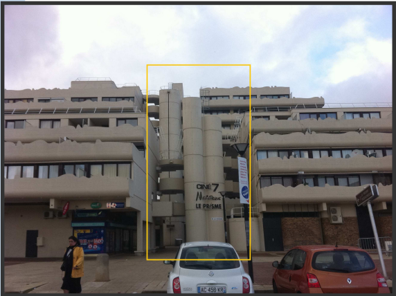
Immeuble La Vague – Elancourt : Importants dépôts d’humidité dans les parties communes : Etudes et propositions de travaux. (2012). Economiste SAS DUVAL
