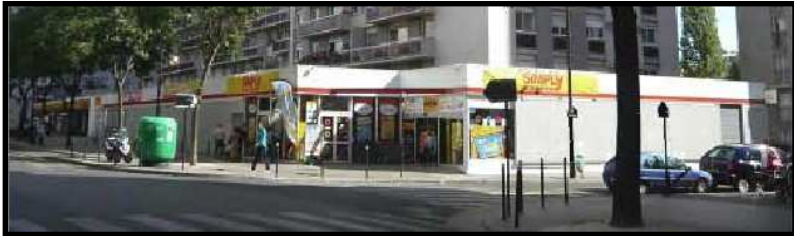
RT Existant : Rénovation et agrandissement du Simply Market Alesia (2013)
